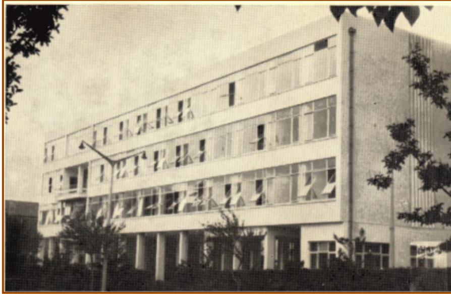
1967 yılında hizmete açılan mevcut belediye hizmet binası
