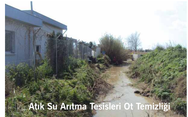
Atık Su Arıtma Tesisleri
