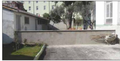
Üç Eylül İlköğretim O.duvarı yapıldı
