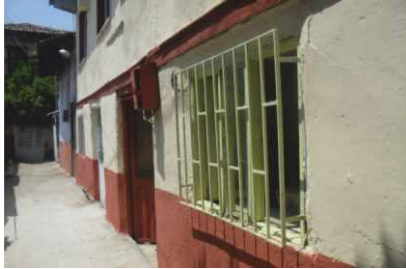
Göçmen Sokak 1. çıkmaz
