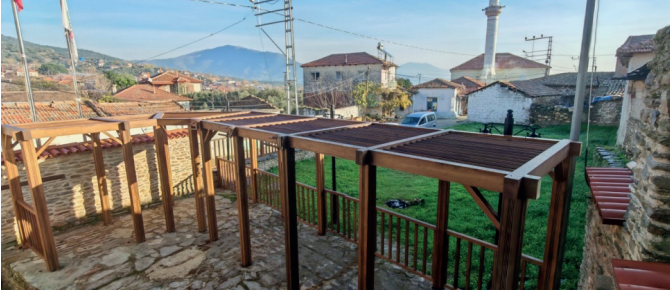
Çakırcalı Mehmet Efe Konağı Tadilat Uygulama İşİ
